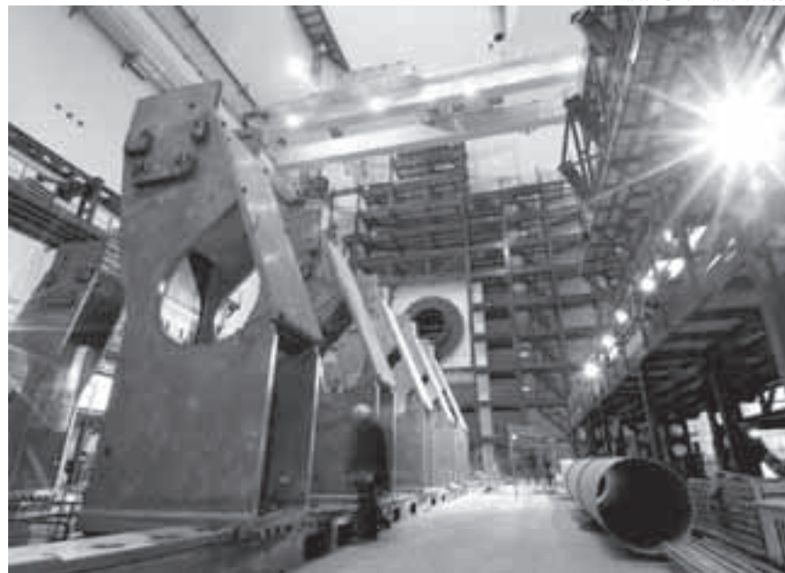
ATLAS-koeasema on vasta rakenteilla. Kuvassa näkyy ilmaisimen tukirakenteet.
