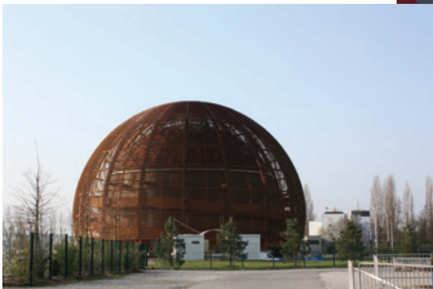
The Globe of Science and Innovation on CERNissä oleva puusta rakennettu näyttelyrakennus.
